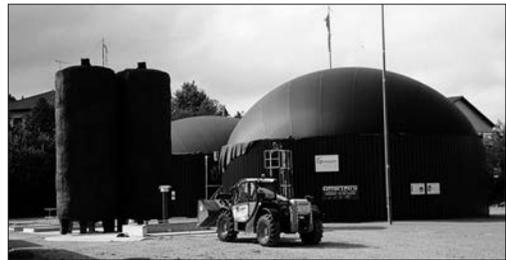
Figure 10: Les deux silos digesteurs
