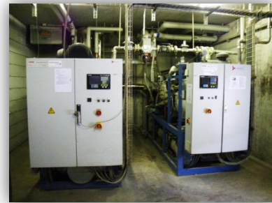
Figure 3 : deux moteurs électriques
