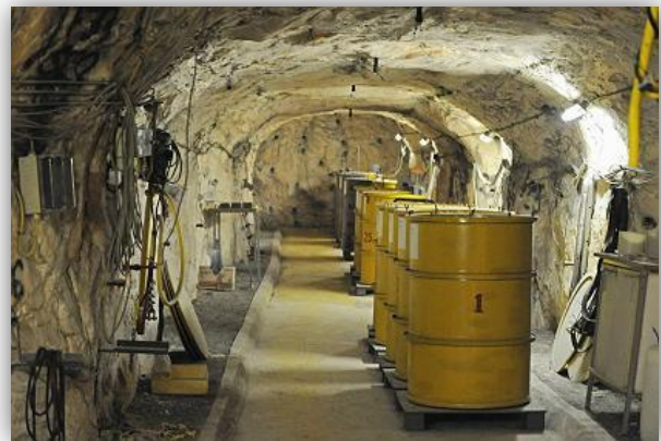
Figure 17 : stockage des déchets nucléaires
